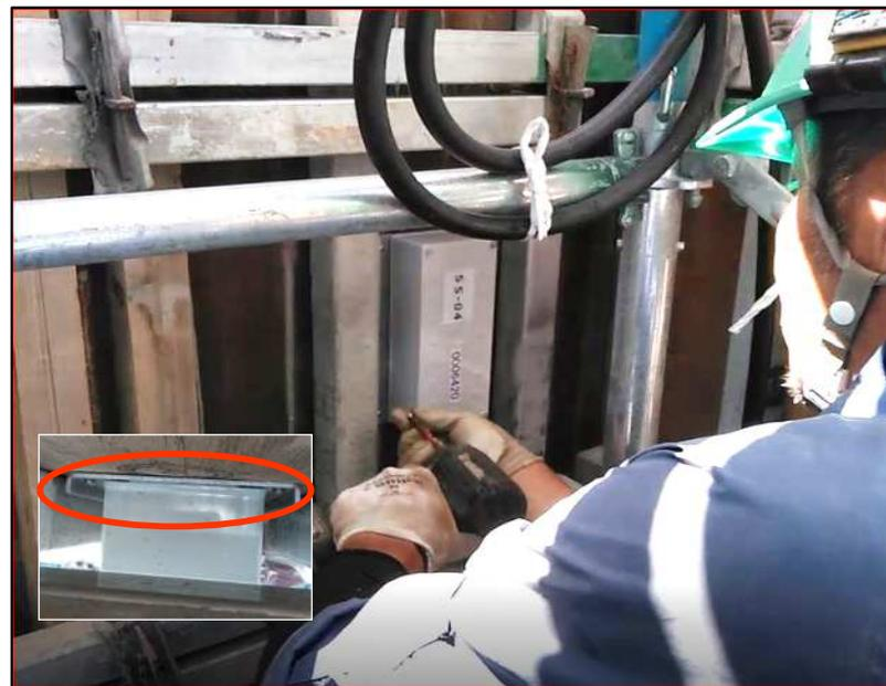
5) 最後に型枠表面を確認し凸部と型枠面が同一面になっているか確認します。
